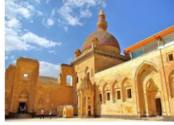
İshak Paşa Sarayı 1685- 1784 - Ağrı- Osmanlıda ısıtma sistemi olan tek yapıdır. Atık su kanalları vardır.
