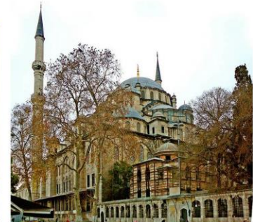
Fatih Külliyesi Cami - Merkez Kubbeli -
